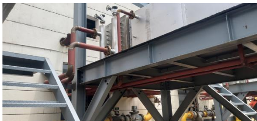
更换锅炉节能器和冷凝器
